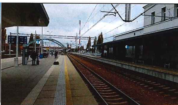
Dworzec PKP po modernizacji (2025)
