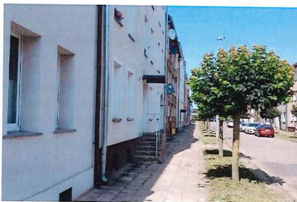
Budynki komunalne przy ul. A. Mickiewicza
